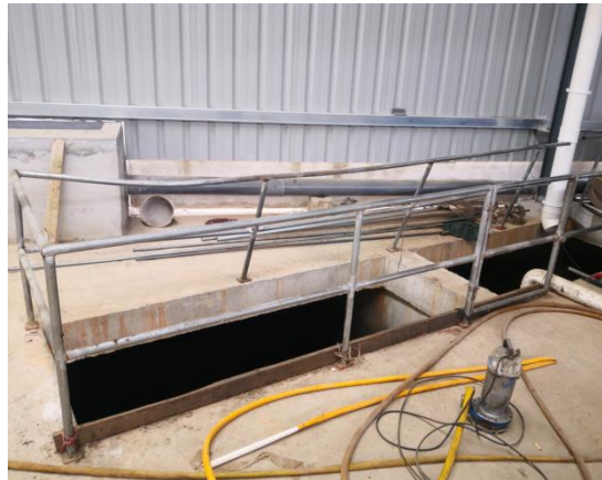
隔油池和调节池
