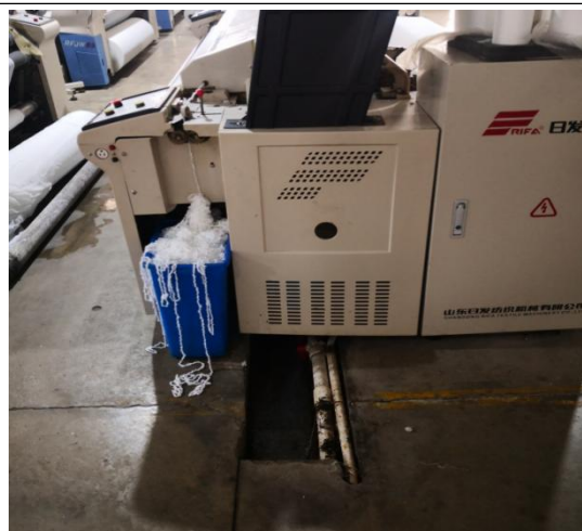
喷水织机车间废水沟渠
